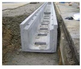
横の写真のようにU字溝の下の平らに なっている部分に、基礎材(砕石等) を敷き詰めます。ある程度固めた 後に基礎コンクリートを打ち、 敷モルタルを敷きレベルスペーサーにて 高さ調整を行いながら二次製品を 置いていきます。
